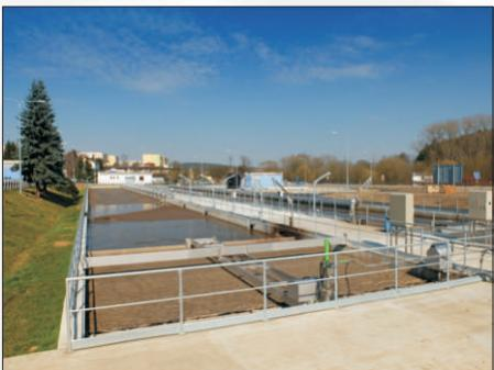
V letech 2012 - 2014 proběhla intenzifikace a rozšíření čistírny odpadních vod Benešov s navrhovanou biologickou kapacitou 53 750 EO. Technologická linka čistírny odpadních vod je navržena jako mechanicko-biologický stupeň s kalovým a plynovým hospodářstvím a chemickým srážením fosforu. Koncepce čistírny je řešena jako systém pro odstraňování uhlíkatého znečištění, biologickou nitrifikaci a denitrifikaci a chemickou eliminaci sloučenin fosforu.
